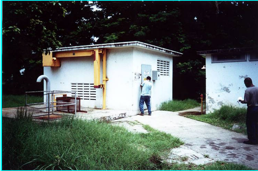
FotoN°2.2.8.17 -Estación de bombeo de Balboa, condición actual, 11 de julio de 2000.
