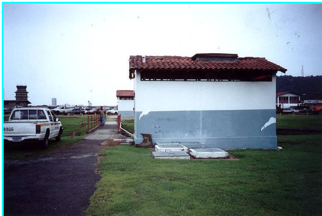
FotoNº2.2.8.16 -Estaciones de Bombeo de Albrook # 1 y #2, condición actual, 11 de julio de 2000.
