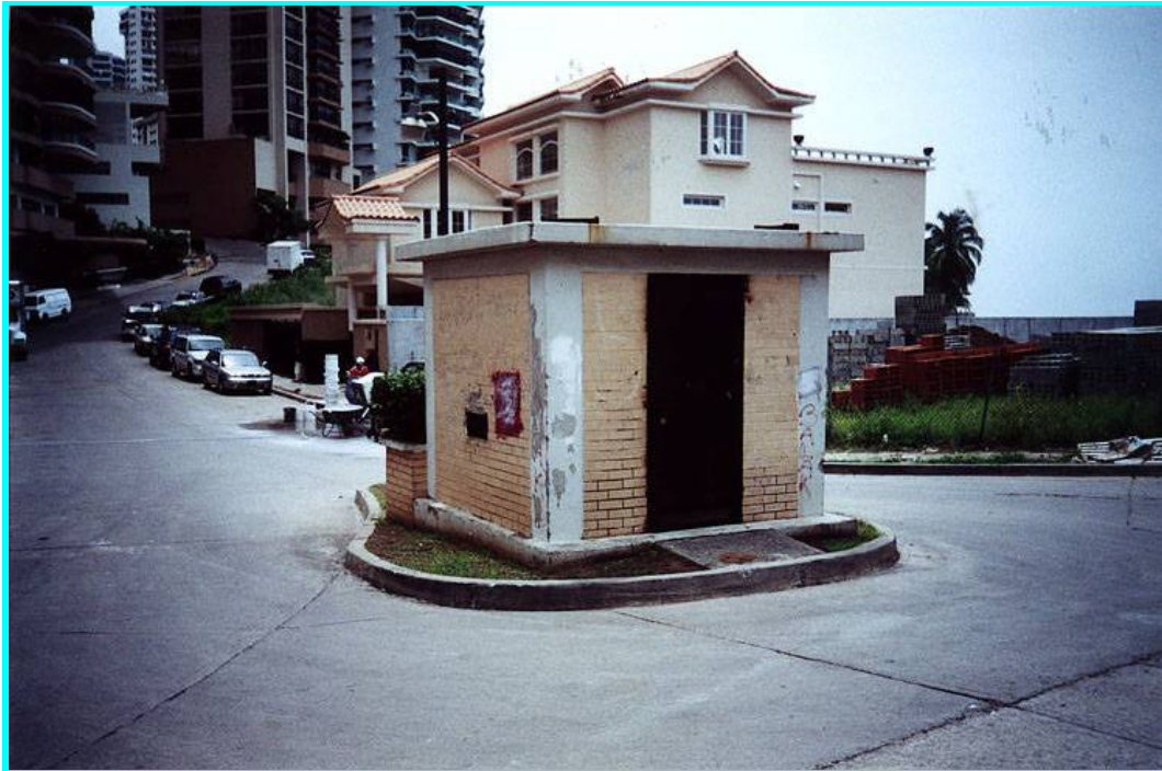
FotoNº2.2.8.15 -Estación de bombeo de Meresías, condición actual, 11 de julio de 2000.
