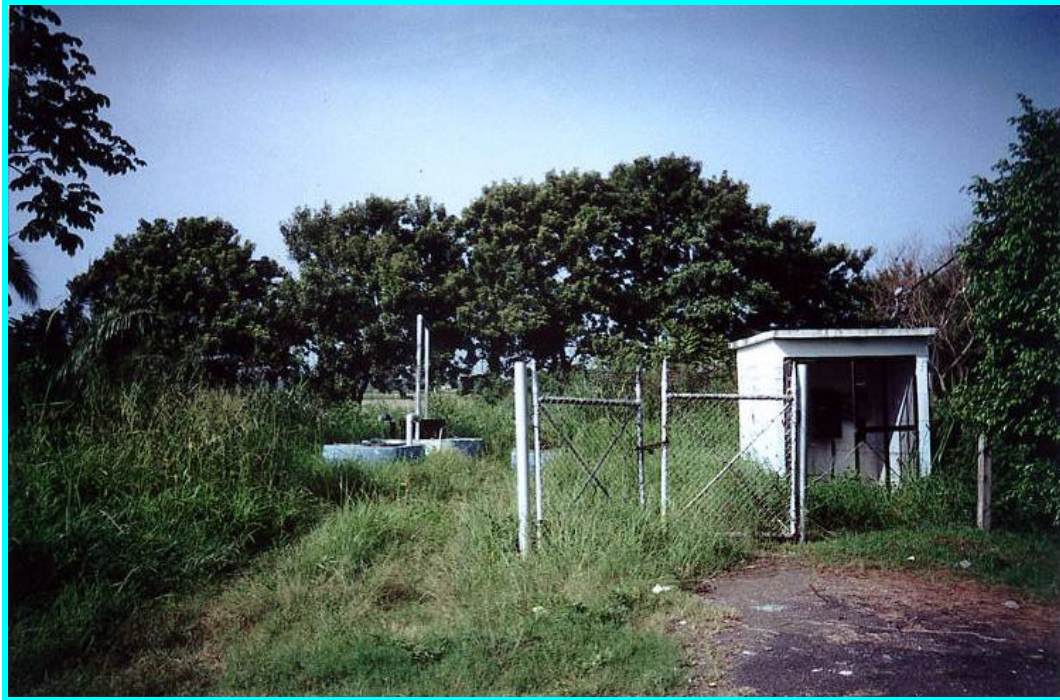
FotoNº2.2.8.9 -Estación de bombeo de ANASA, condición actual, observar la falta de corte de herbazal y de la cerca perimetral.
