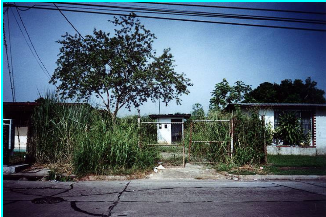
FotoNº2.2.8.10 -Estación de bombeo de las Acacias. Observar la necesidad de cortar el herbazal y de una cerca perimetral.
