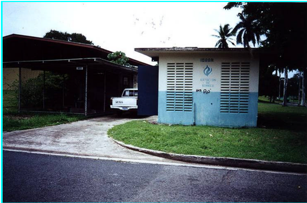
FotoN°2.2.8.18 -Estación de bombeo de Pedro Miguel, condición actual, 11 de julio de 2000.
